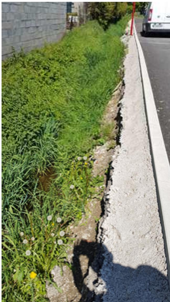
La conduite d'eau potable se trouve également du côté de la voirie impactée. En cas d'effondrement de la voirie la conduite sera endommagée.
