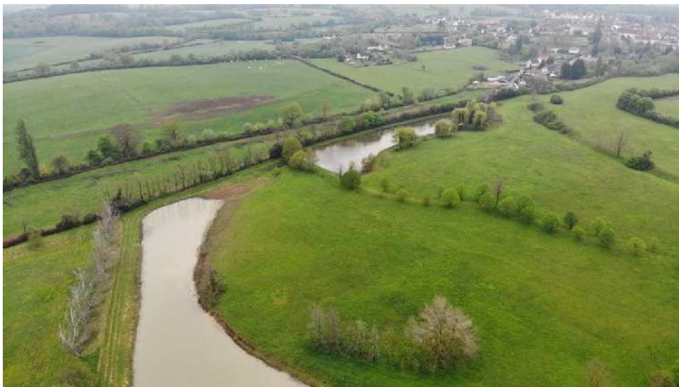
Photographies aériennes de la zone des Jacquets (45-8 ENERGY, 30 avril 2021)
