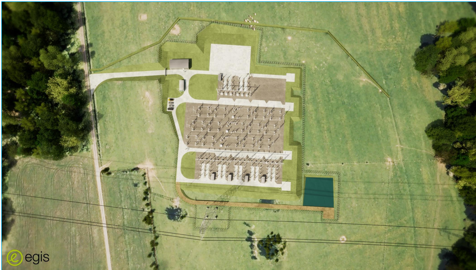
Vue aérienne prise au dessus du poste de MALVILLERS
