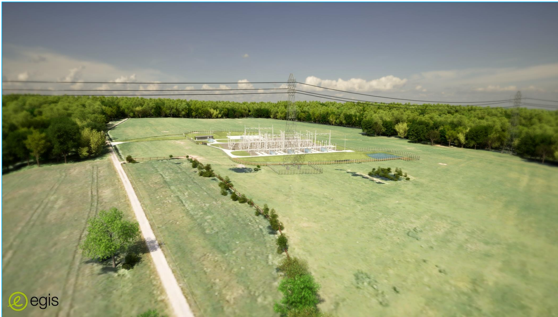
Vue aérienne prise depuis le chemin d'accès au futur poste
