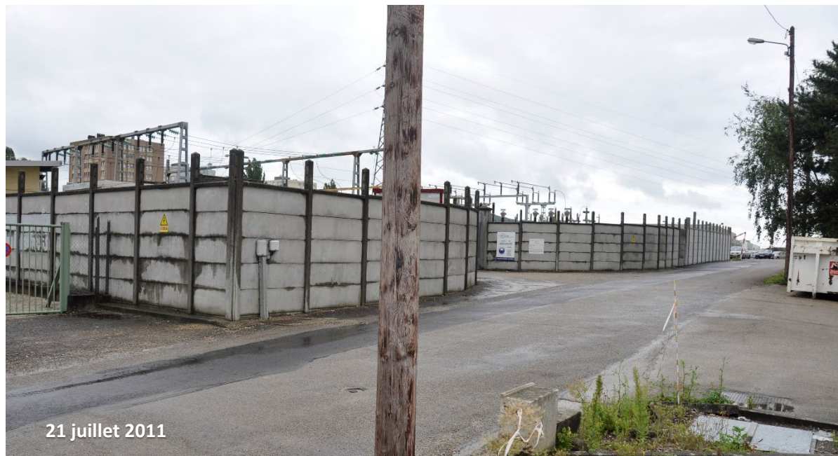
Vue 1 : Vue sur le poste depuis la rue permettant d'accéder au site
