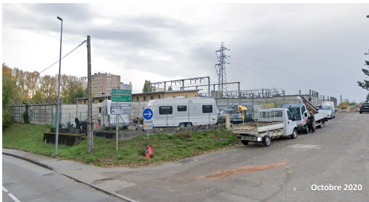
Vue 2 : Vue sur le poste en arrivant de la rue Lavoisier par le nord
