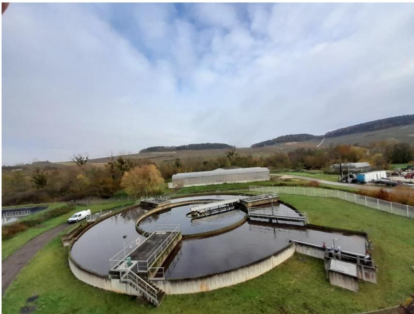
**Photo 4** : Vue du haut de la station d'épuration : Bassins de boues activées, clarificateur et serres de séchage des boues
