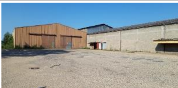
Photographie 1 : Local compresseur et abri de stock d'huiles
