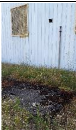
Photographie 5 : Cuve enterrée
