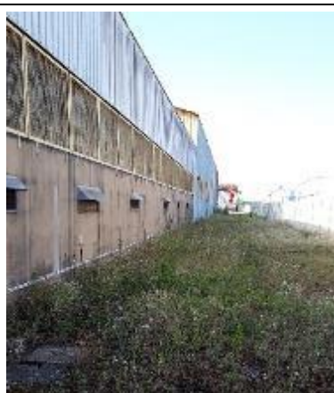
Photographie 6 : Réseau de séparation des rejets
