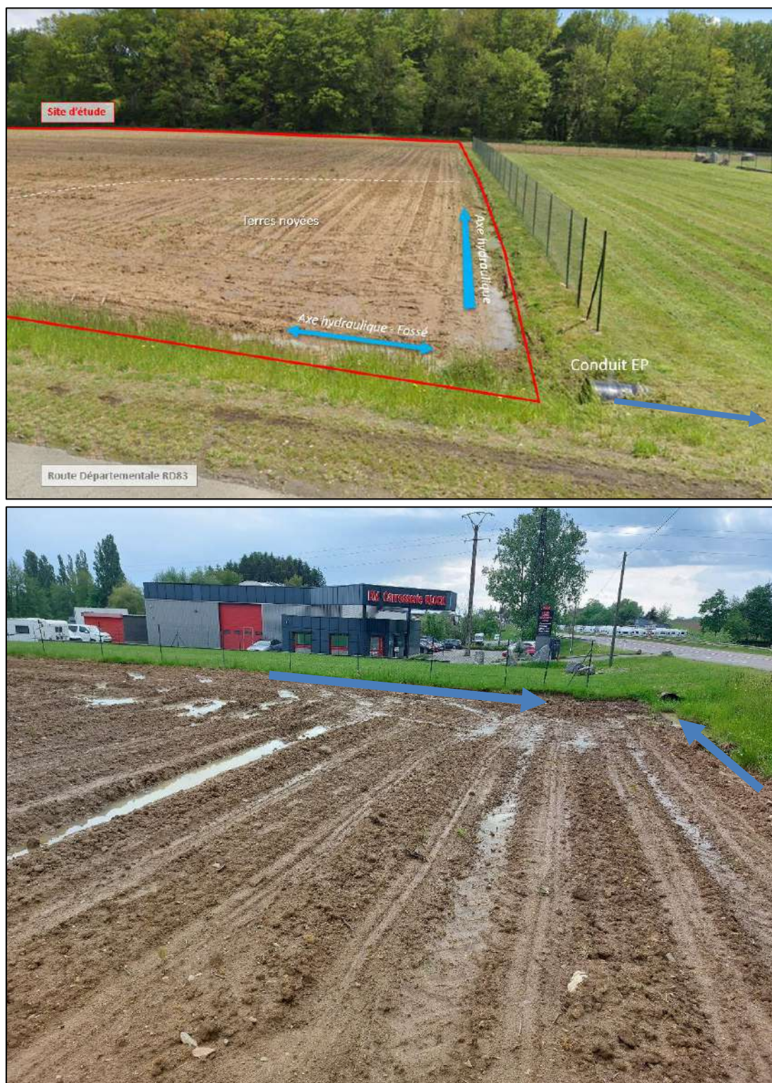
Figure 7 : Photographie de l'accumulation d'eau au niveau des points bas du site – (en haut Google Street View -Mai 2021, en bas ECR Environnement – Mai 2023)
