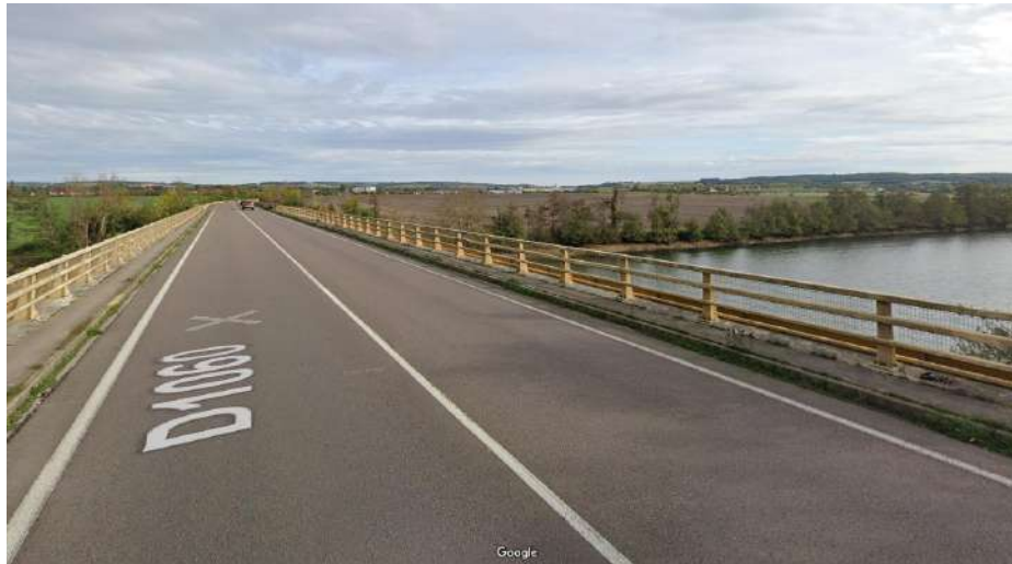
Figure 83 : Pont de Salcy – Source : googlestreetview2022
