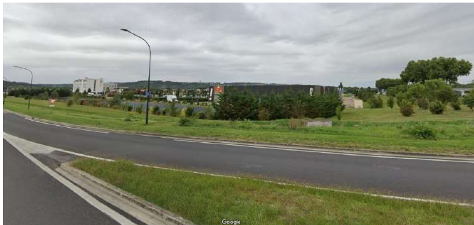
Figure 84 : Vue de la zone d'activité du site d'étude depuis le giratoire de la D1060 et D606 – Source : Googlestreetview 2023
