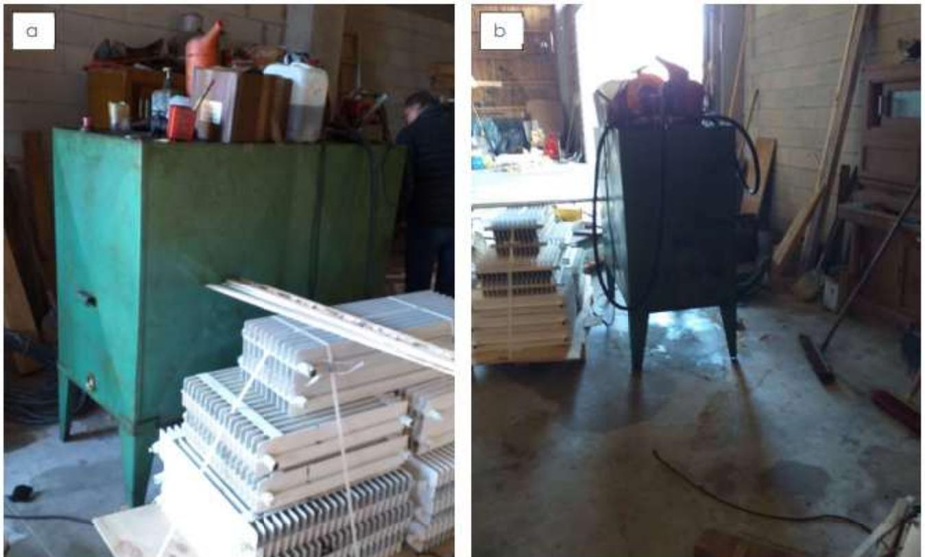
Photographie 3 : Cuve aérienne de gasoil au droit du bâtiment de traitement du bois
