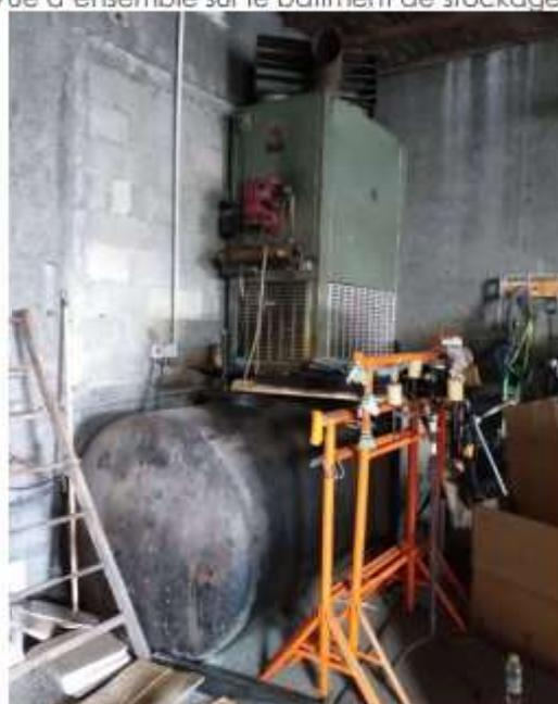
Photographie 11 : Cuve de FOD présente dans le bâtiment de stockage
