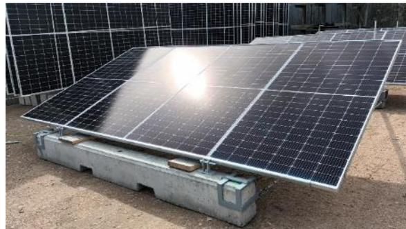
Les 1352 modules de panneaux photovoltaïques (Puissance unitaire : 580 Wc ; Surface unitaire : 1039 x 2095 mm = 2,18 m<sup>2</sup>) produiront environ 784,16 kWc (932 MWh/an) ; Ils seront regroupés par 4 sur des structures métalliques fixées à des longrines préfabriquées en béton (Montage et câblage des panneaux en usine).
