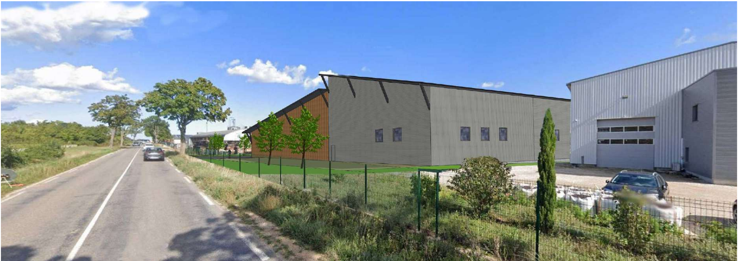
VUE DEPUIS LA ROUTE DE CLUNY (SUD)
