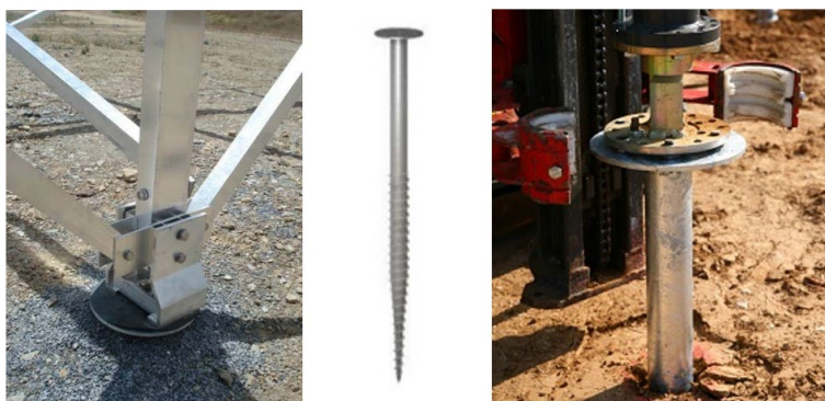
Figure 4- Exemple de fondations à visser - Q ENERGY France
