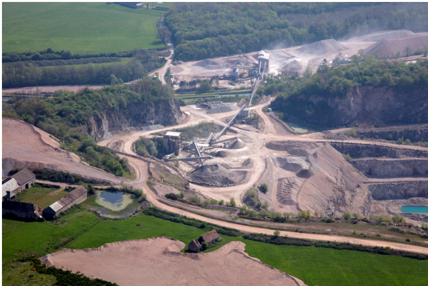
Installations de traitement
