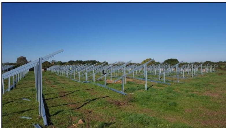
Figure 5 : Mise en place des structures sur pieux battus (centrale JPee de Braize, 03)
