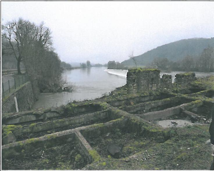
*Le bâtiment en ruine de la centrale du Moulin d'Arrenthon, le 10 janvier 2012 ; au second plan, le seuil sur le Doubs, qui permet de créer un plan d'eau de niveau constant en amont de la prise d'eau – photographie DREAL FC.*
