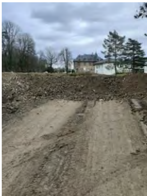
Figure 66 : Planche photographique de la réalisation des travaux de déconstruction de l'existant en partie nord de l'AEI (de haut en bas : situation au 22 mai 2023, situation au 11 octobre 2023, situation au 27 octobre, situation au 8 novembre 2023, fin des travaux au 29 février 2024)
