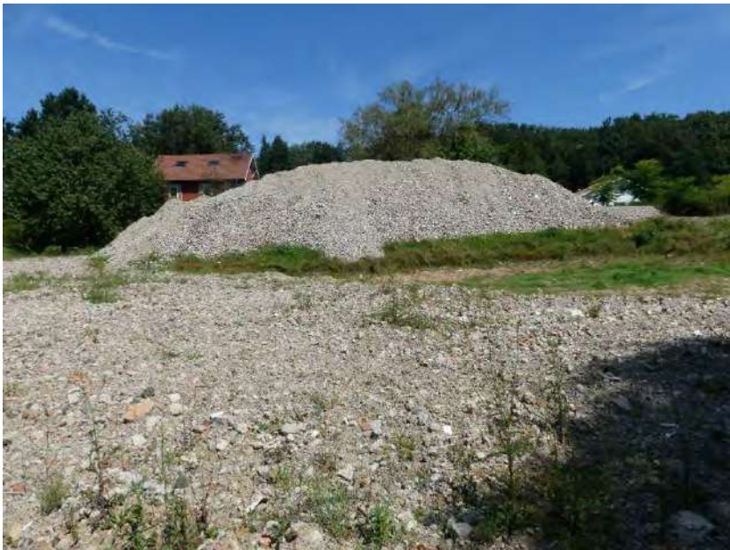
Figure 39 : Tas de gravats
