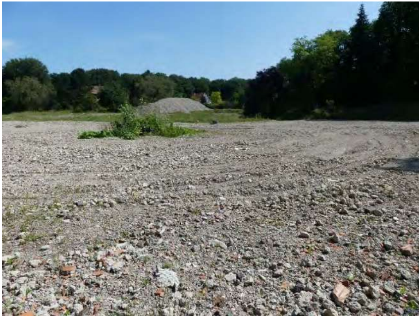
Figure 36 : Remblais de construction
