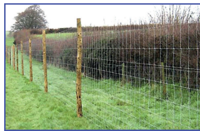
Clôture de type agricole
