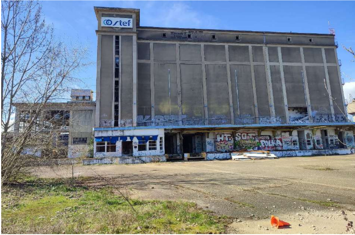
5) Bâtiment principal à démolir, vue depuis la route de Lyon, le 19 mars 2024
