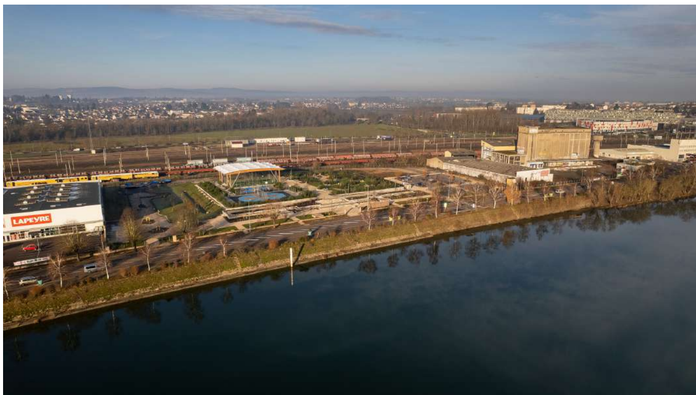
2 ) Prise de vue en drone depuis la Saône le 23 décembre 2021
