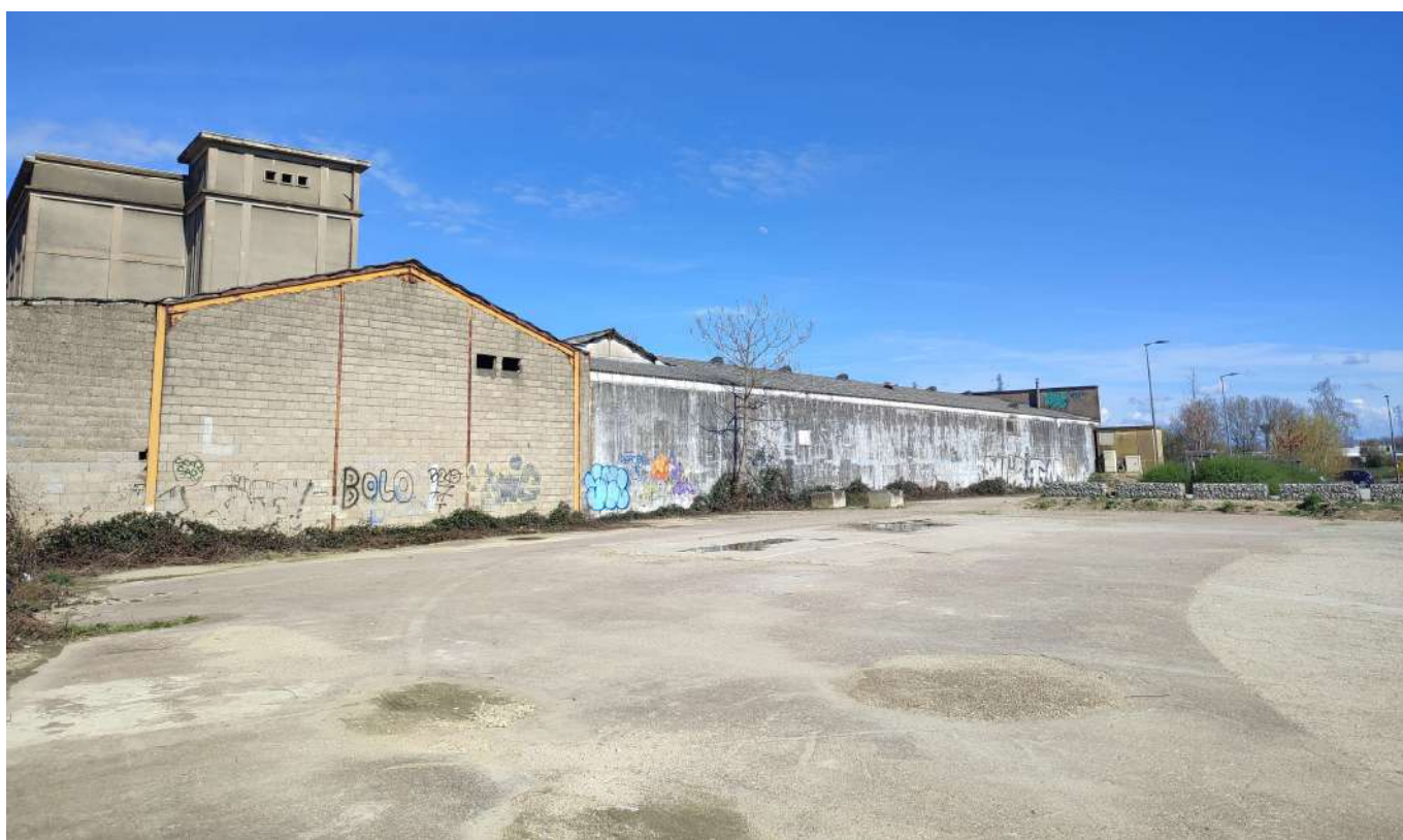
4) Bâtiments annexes à démolir et emprise pour l'extension du parking, le 19 mars 2024
