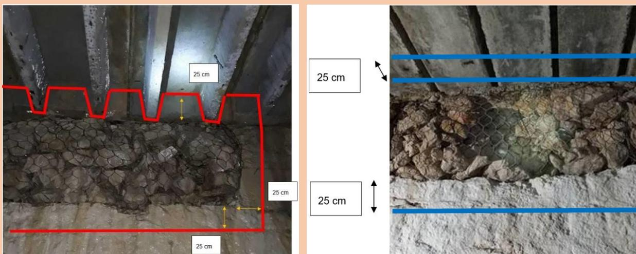
Figure 1 : Schémas de principe de pose du nouveau grillage - Présence des poutres précontraintes ( à gauche ) ; Absence des poutres précontraintes (à droite)
