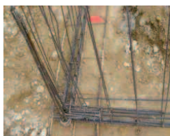
Mise en place d'un chaînage au niveau du rampant d'un bâtiment
