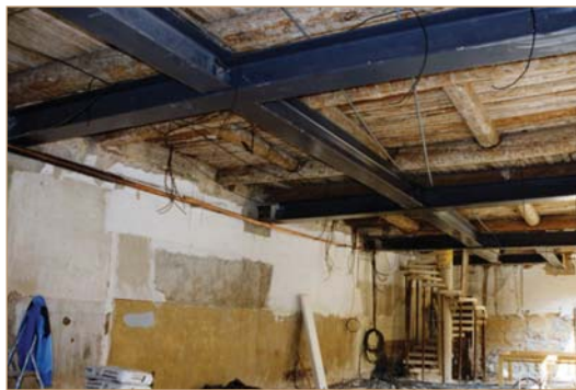
Renforcement de planchers en bois sur un bâtiment ancien
