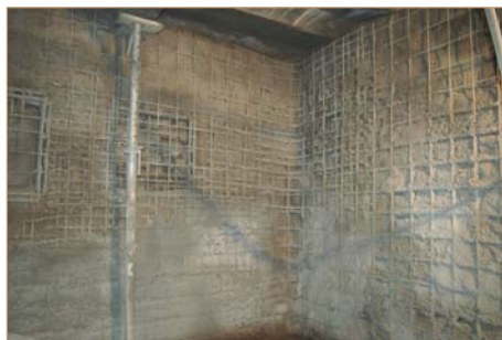
Renforcement de murs porteurs en maçonnerie sur un bâtiment ancien
