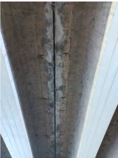
Anfractuosités favorables aux chiroptères dans le pont du Doubs
