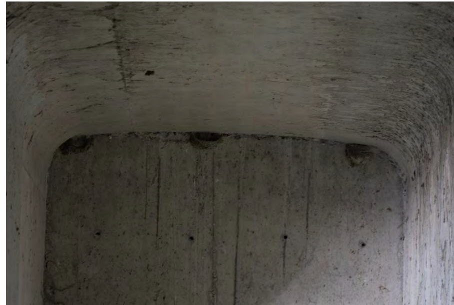
Nids d'Hirondelle rustique sous le pont du viaduc du Doubs
