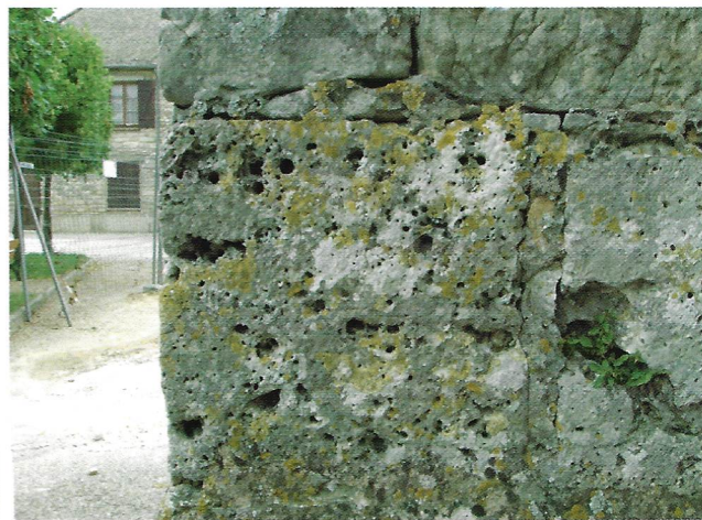
Recouvrement de grès par des lichens et mousses diverses. Moigny-sur-l'Ecole.
