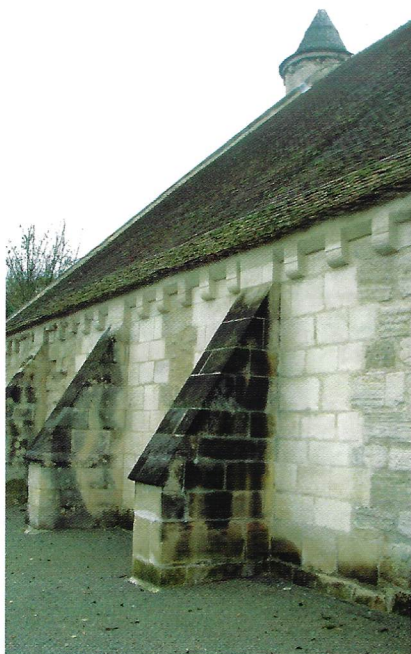
Salissures noires d'origine biologique (cyanophycées) sur les zones humides de contreforts en calcaire. Grange à dîmes. Saint-Quen-l'Aumône.
