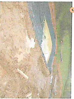
Piège à sédiments positionné en bas de pente avec fosse de récupération des écoulements.
