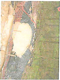
Piège à sédiments de forme ronde, inadaptée à la décantation des sédiments.
