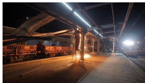
Dépose de l'abri voyageurs du quai 3
