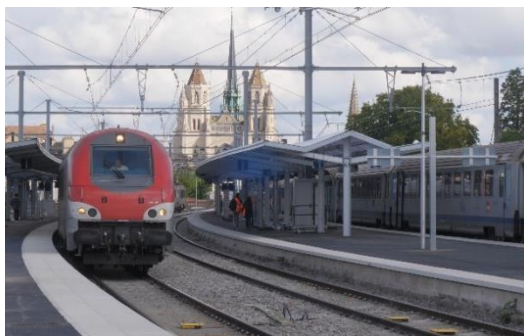
Nouvel abri de quai installé
