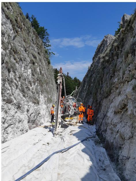
Confortement par pose de grillages sur les parois des tranchées du tunnel de Malproche
