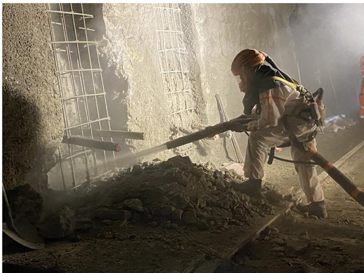
Confortement par béton projeté des parois du tunnel de la Savine
