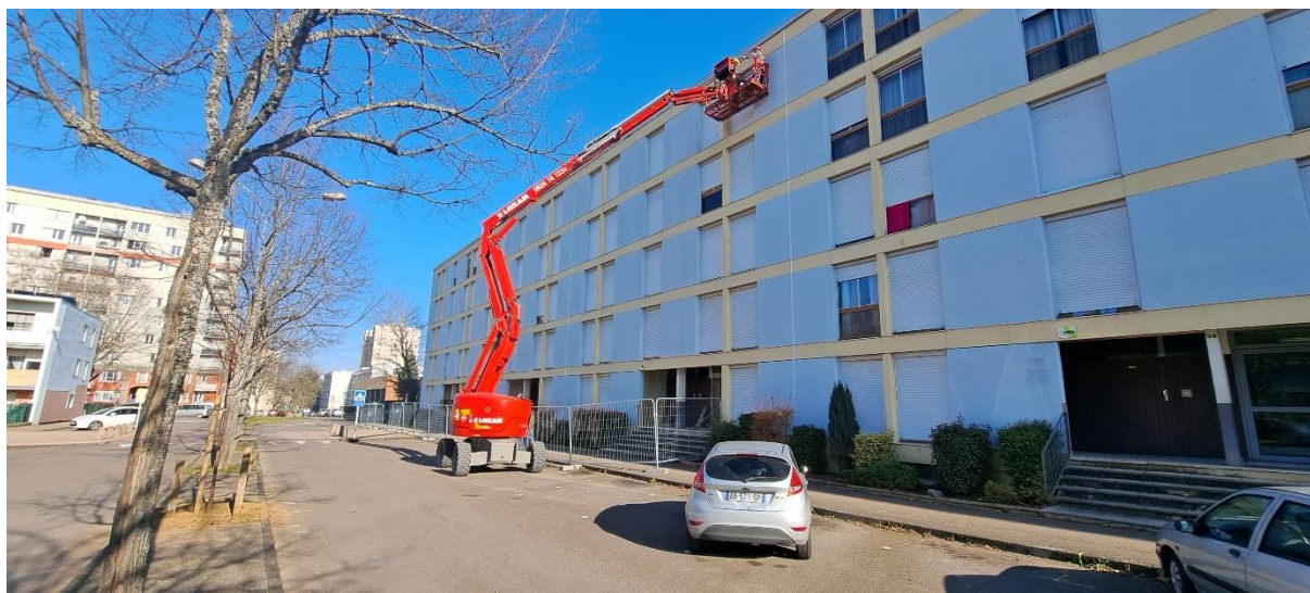
Illustration 1 : Intervention sur l'immeuble grâce à une nacelle.
