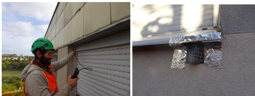
Figure 2 : inspection d'un caisson de volet roulant et exemple de système anti-retour mis en place
