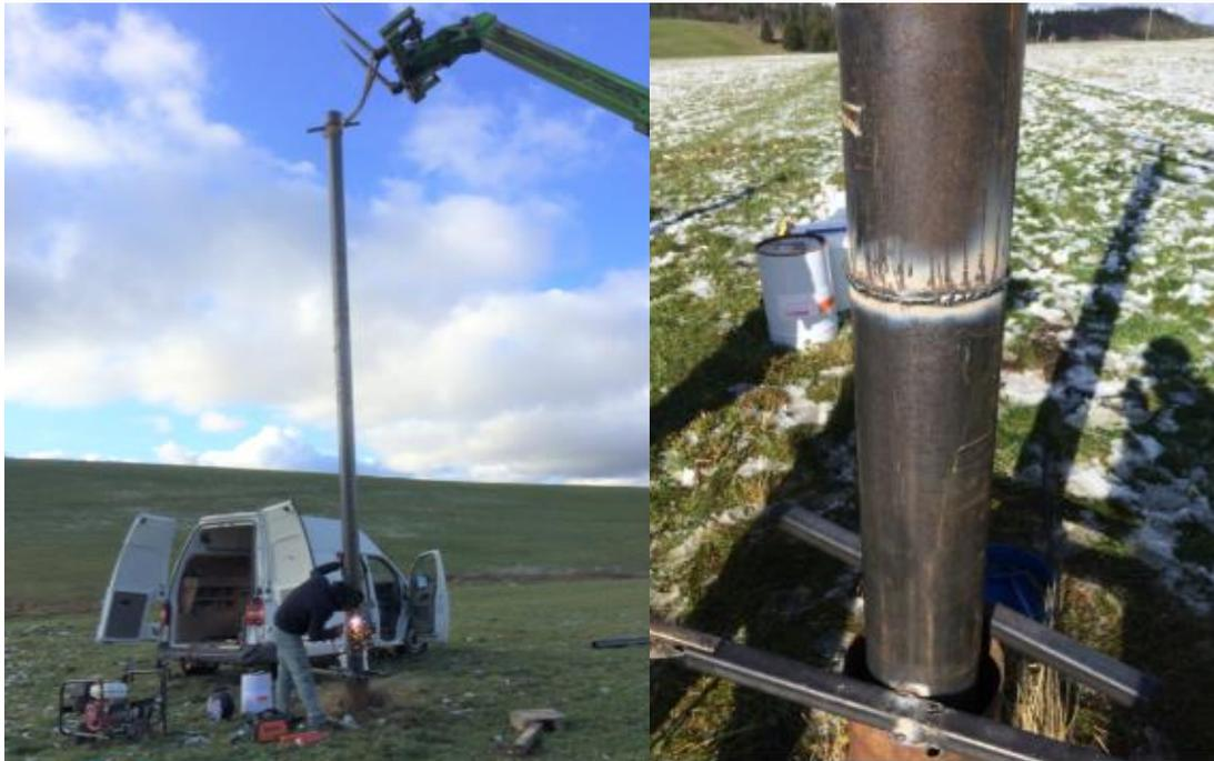
**Figure 9 : Installation des tubages acier**
