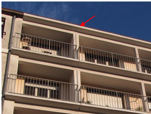
Photos 2: Joints de dilatation au niveau de l'avancée de toit (façades est et ouest)
