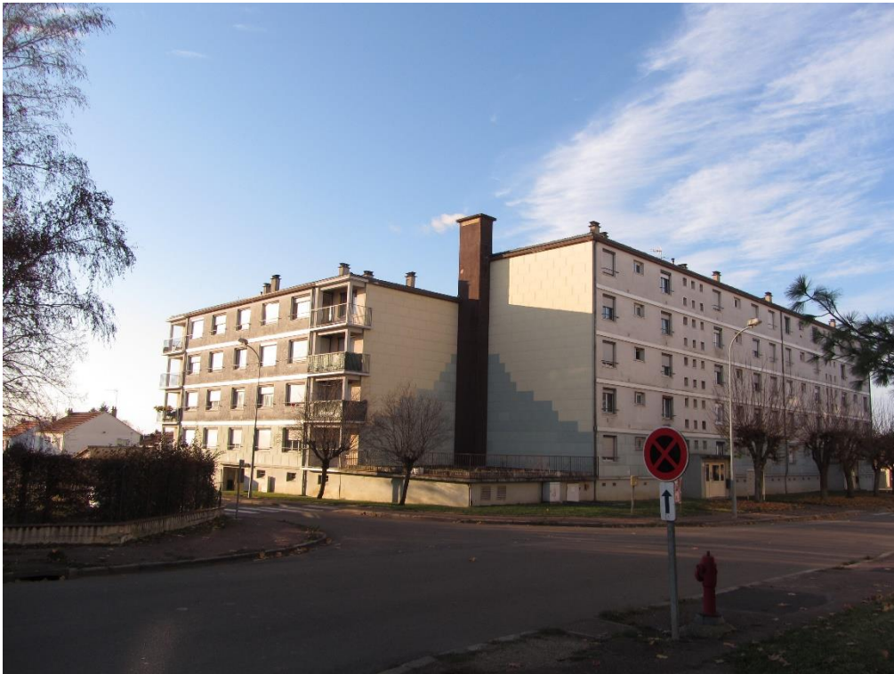
Photo 1 : Vue du bâtiment.
