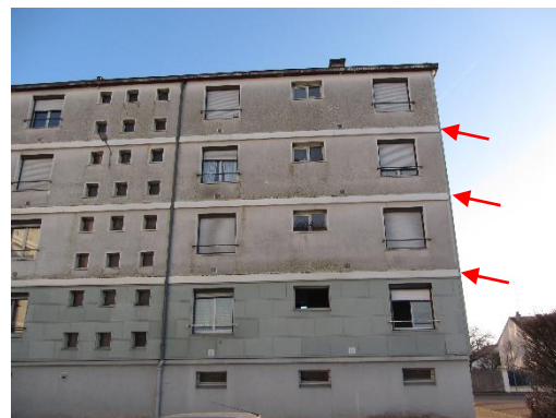
Photos 3: Plaques métalliques entre chaque étage, accessibles aux extrémités.
