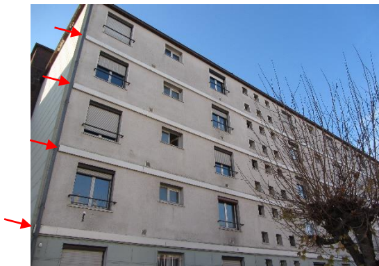
Photos 3: Plaques métalliques entre chaque étage, accessibles aux extrémités.
