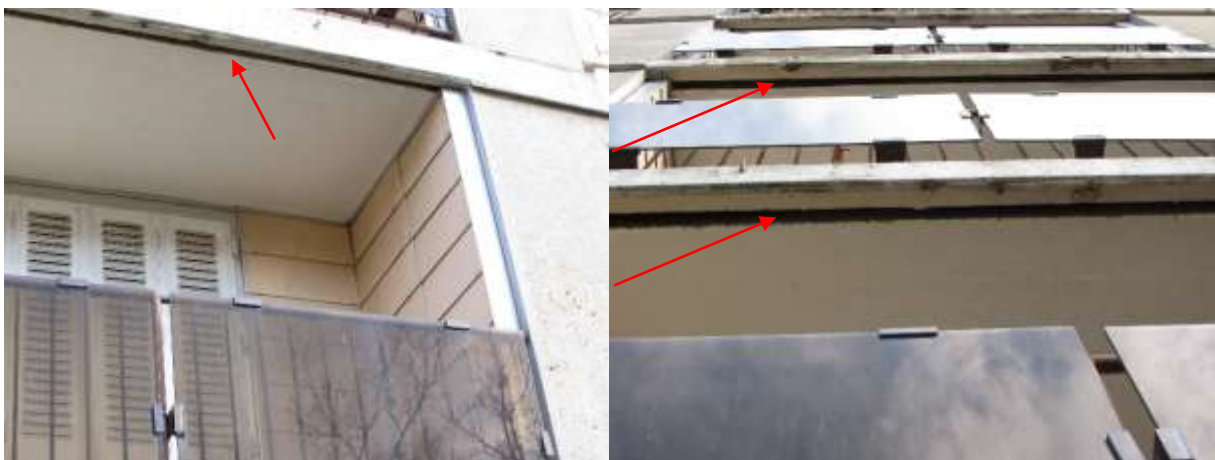
Photos 2: Espaces favorables au niveau des balcons.
