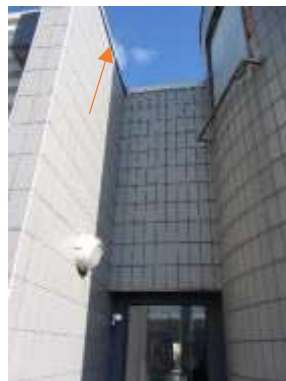
Photo 13 : Espace derrière une couverture sur le bâtiment Le Phare.
