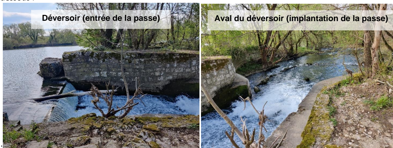
Figure 47 | Secteur d'implantation de la passe à poissons.
