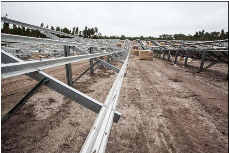
Figure 9 : Exemple de table fixe de modules
