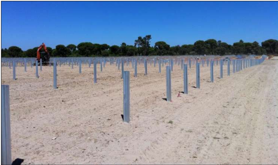
Figure 22 : Exemple des pieux battus dans le sol, la batteuse est visible à l'arrière-plan
