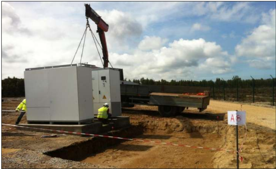
Figure 25 : Installation des postes de conversion
