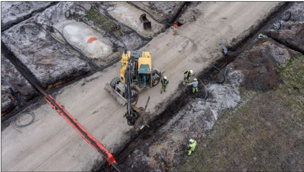
Figure 21 : Mise en place des câbles souterrains
