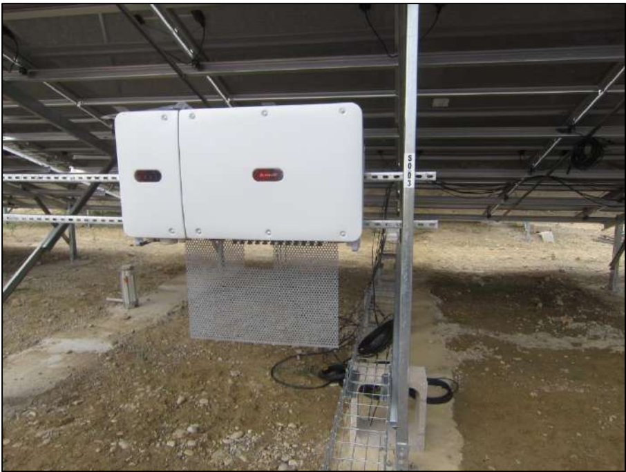
Figure 14 : Exemple d'onduleur décentralisé
