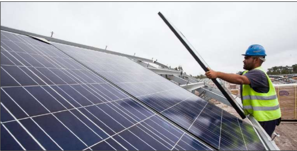
Figure 24 : Exemple de procédé de pose de modules
