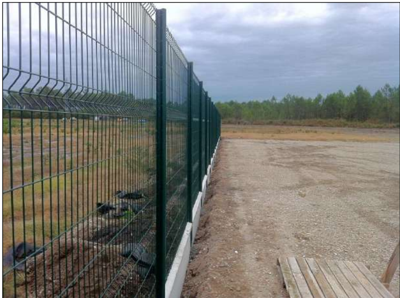
Figure 19 : Exemple de clôture autour d'une centrale
