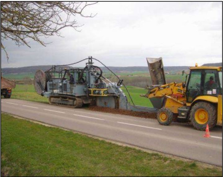
Figure 17 : Réalisation d'une tranchée
