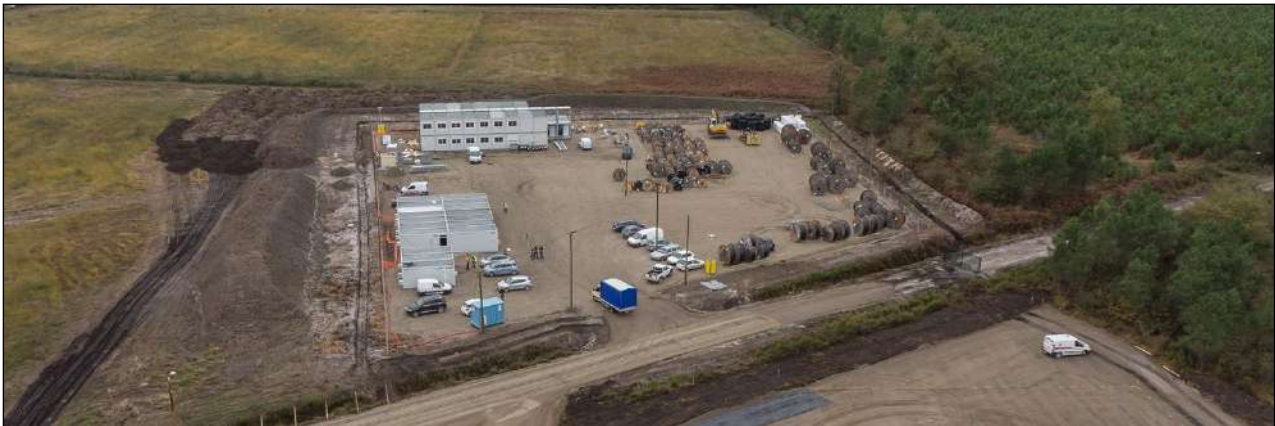
Figure 26 : Exemple de base de vie
