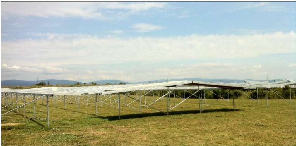
Figure 23 : Structure de tables dans une orientation est-ouest
