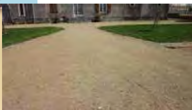
Sable stabilisé avec liant naturel, Plougasnou (29)
