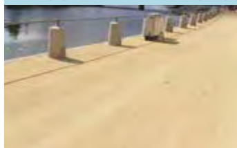
Stabilisé renforcé, sur les quais de la Mayenne à Laval.
