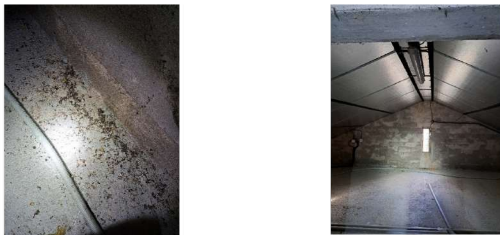
Figure 23 : Photographies des indices de présence de chiroptères (à gauche) et du comble du bâtiment B1 (à droite) (Source : TAUW France)
