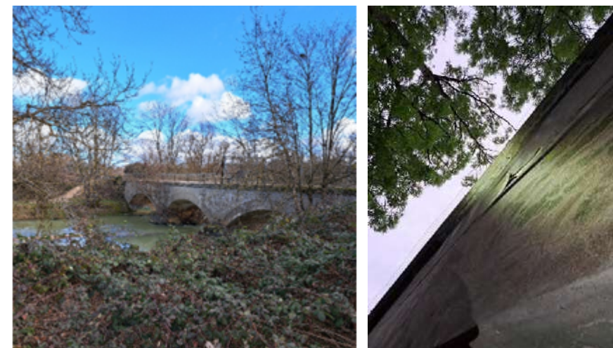
Figure 21 : Pont de l'Ouche situé au nord du site d'étude à côté de la D122A (Source : TAUW France)
