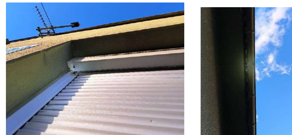
Figure 24 : coffre de volet (à gauche) et accès au comble (à droite) (Source : TAUW France)
