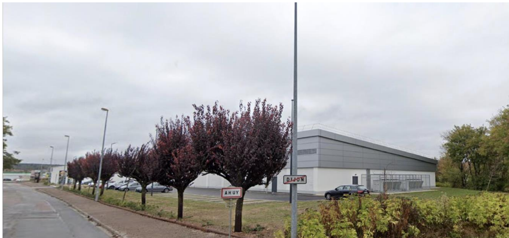
Photographie 1 : Vue depuis le sud du site, à la limite communale avec Dijon
