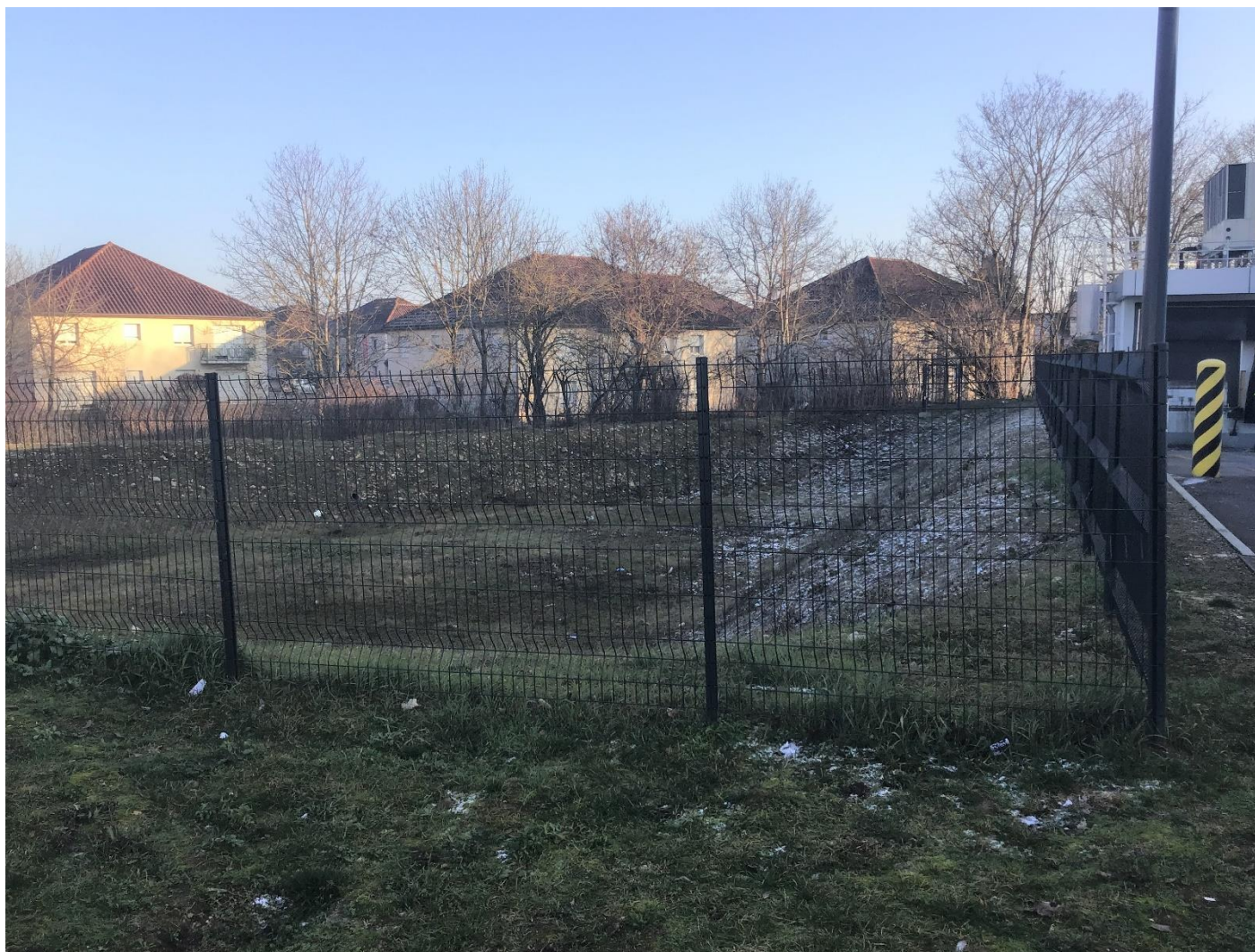
Photographie 6 : Bassin de rétention des eaux pluviales 2/2
