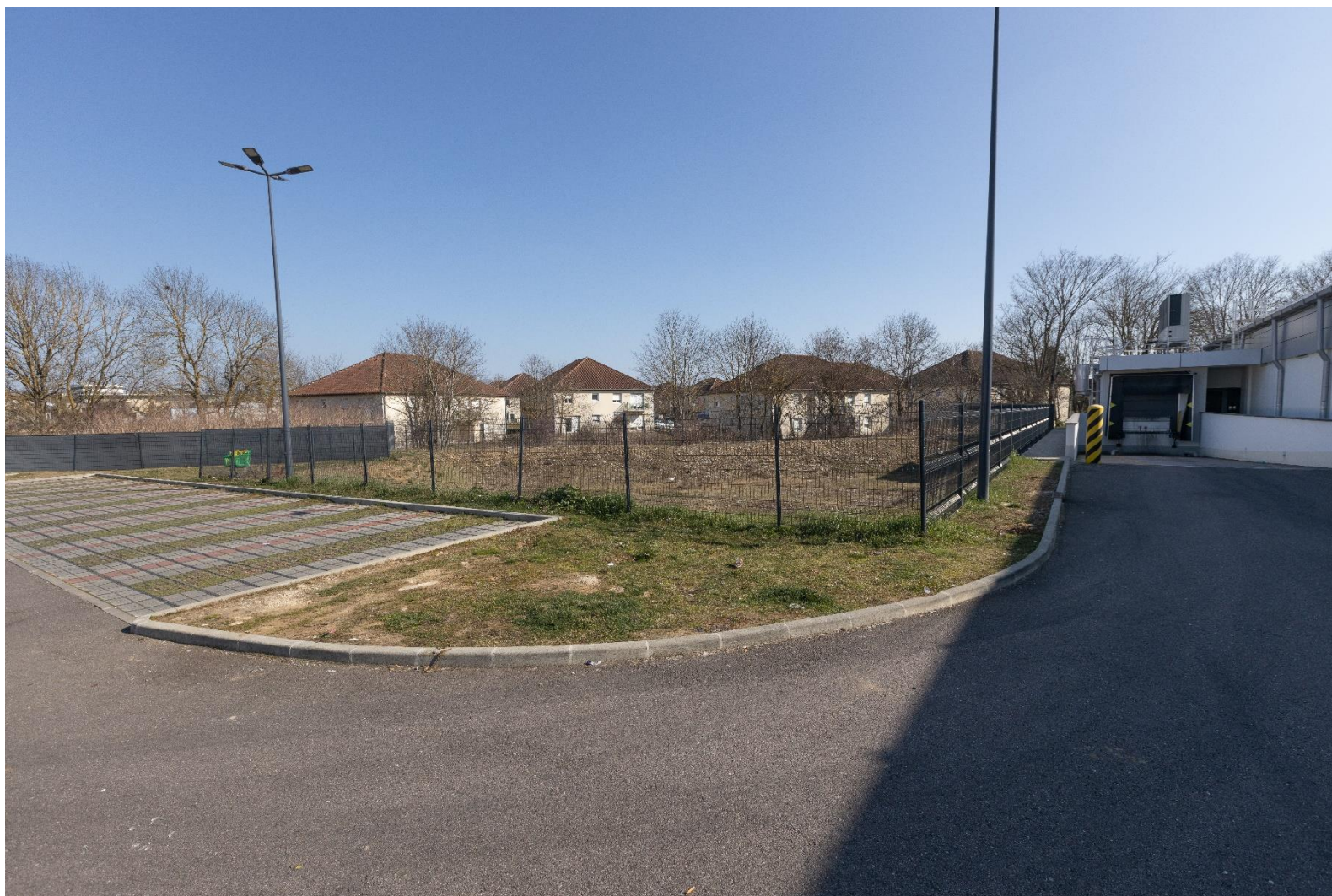
Photographie 5 : Bassin de rétention des eaux pluviales 1/2
