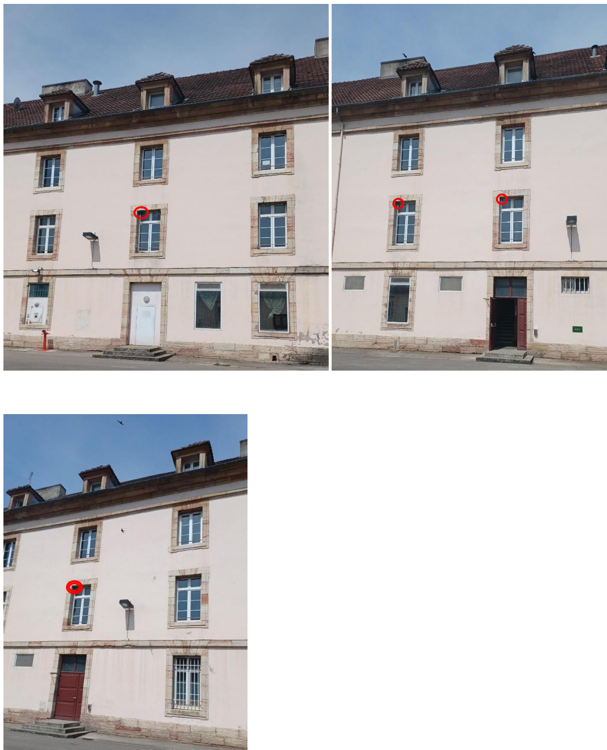
Figure 11 : Colonie d'Hirondelle de fenêtre sur la façade est du bâtiment 0016
