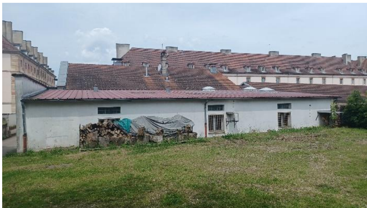
Figure 19 : Façade est du bâtiment 0018 - présence pile de bois favorable à la présence du Hérisson d'Europe
