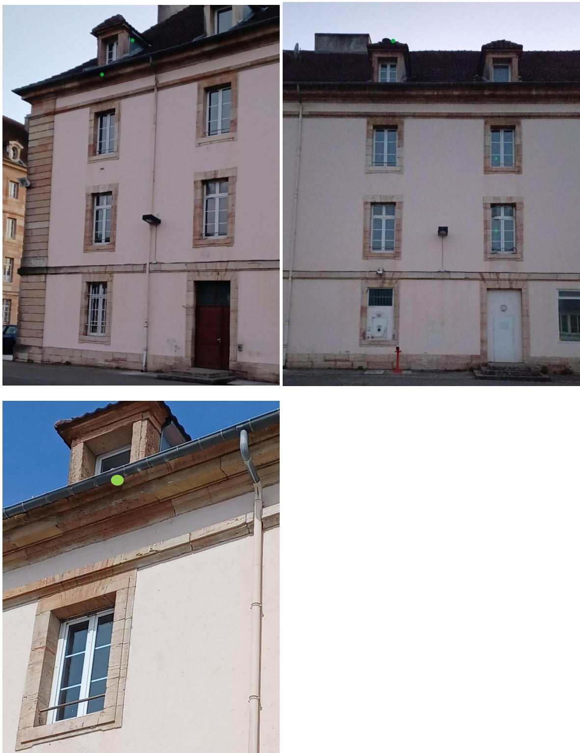
Figure 14 : Localisation des cavités à Martinet noir présentes sur la façade est du bâtiment 0016 (points verts)
