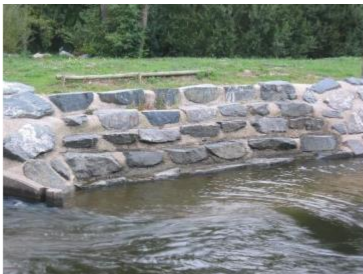
Figure 47 : Principe de mise en œuvre d'un débarcadère en enrochements bétonnés
