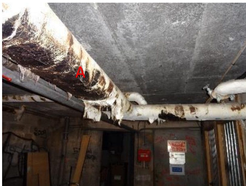
Dépose calorifuge au sous-sol
