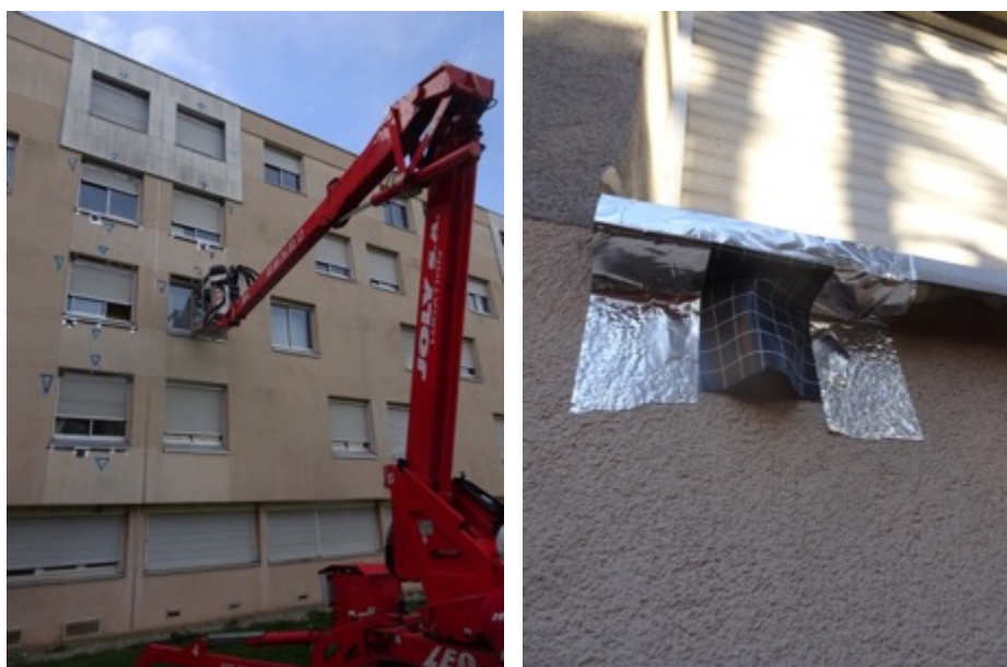
Figure 20 : Réalisation des travaux de condamnation et installation d'un système antiretour sous une tablette de fenêtre.
