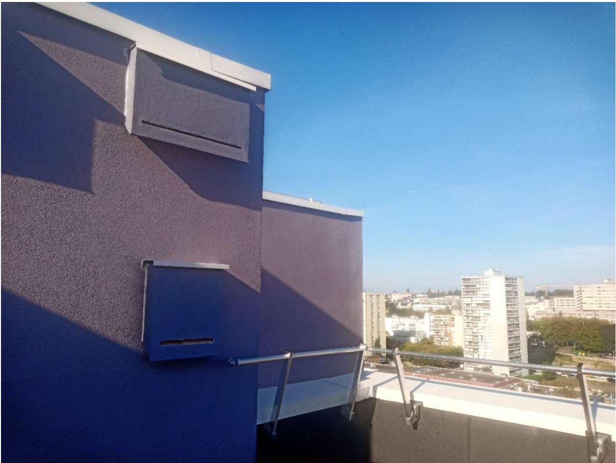
Figure 29 - Exemple de gîtes après la pose de l'isolant
