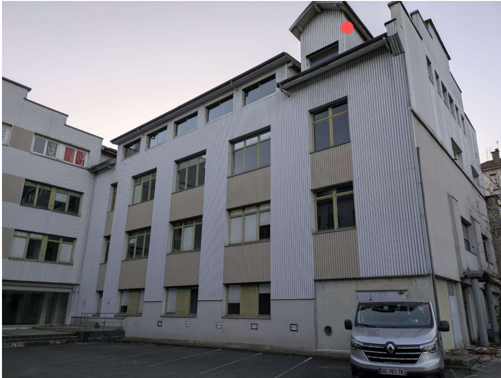
Figure 16 - Chauves-souris type pipistrelle sp. aperçue quittant le bâtiment au niveau du toit du chien assis
