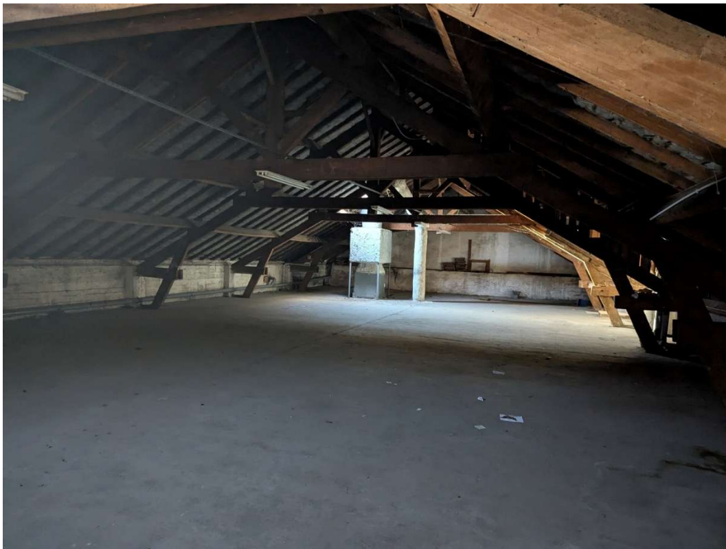
Figure 10 - Comble à l'intérieur du bâtiment 45 avenue Sadi Carnot
