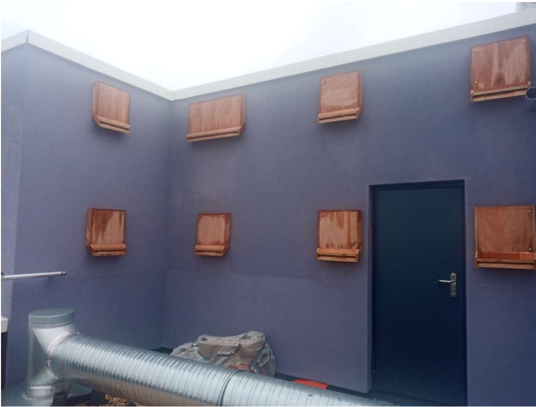
Figure 28 - Gîtes sur façade avant la pose de l'isolant
