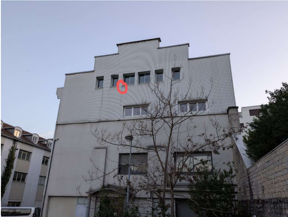
Figure 17 - Chauves-souris type pipistrelle sp. aperçue quittant le bâtiment au niveau de la tablette de fenêtre sous la fenêtre
