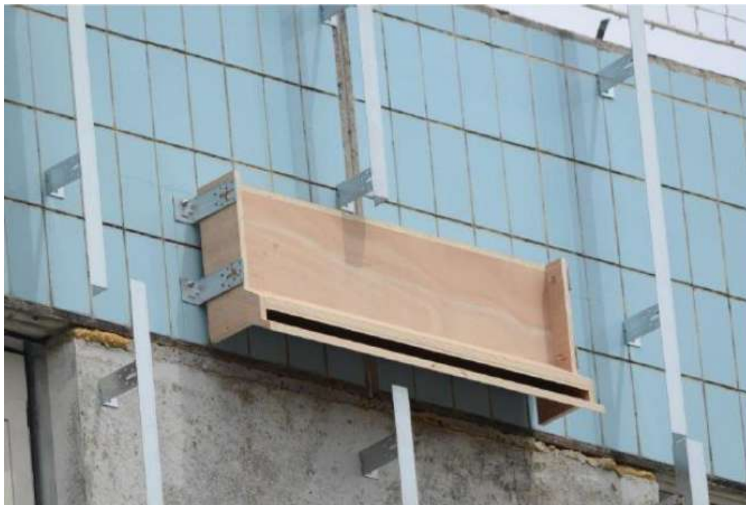
Figure 27 - Gîte plan climat en cours d'intégration dans une façade
