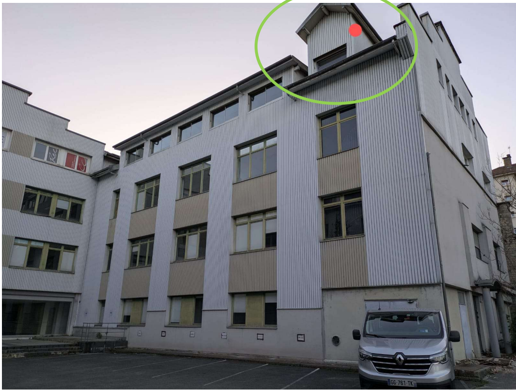
Figure 13 - Chien assis et toiture très favorable aux chauves-souris
