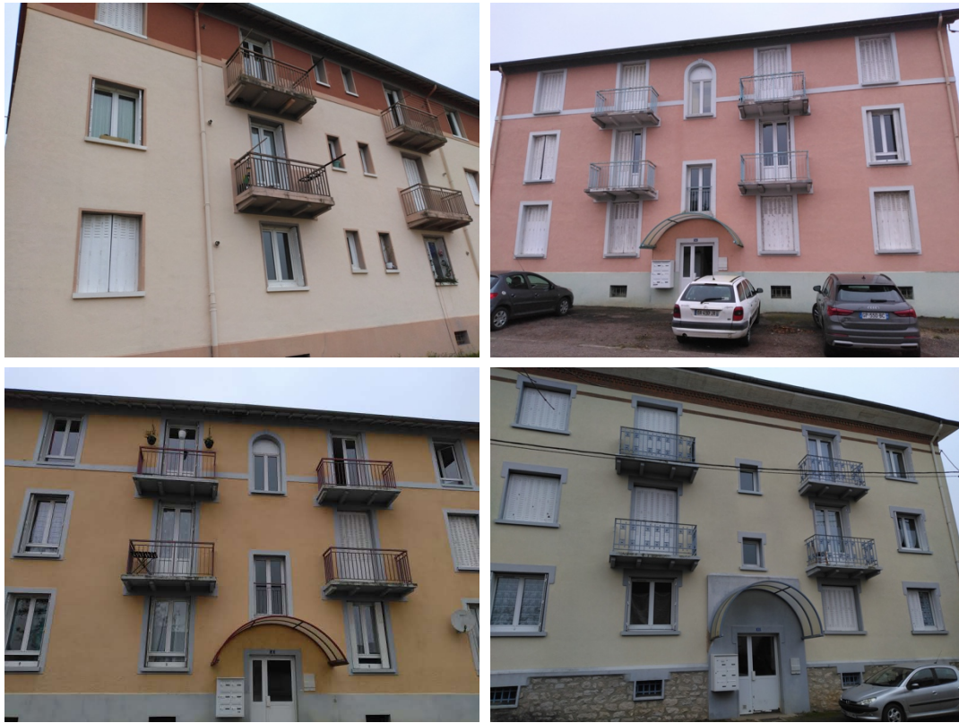
Figure 3 : Bâtiments concernés par l'expertise
