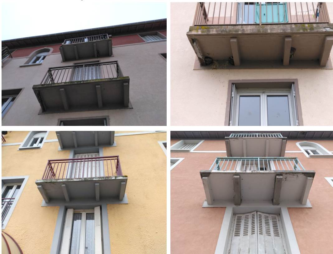
Figure 4 : Balcons observés sur les bâtiments expertisés
