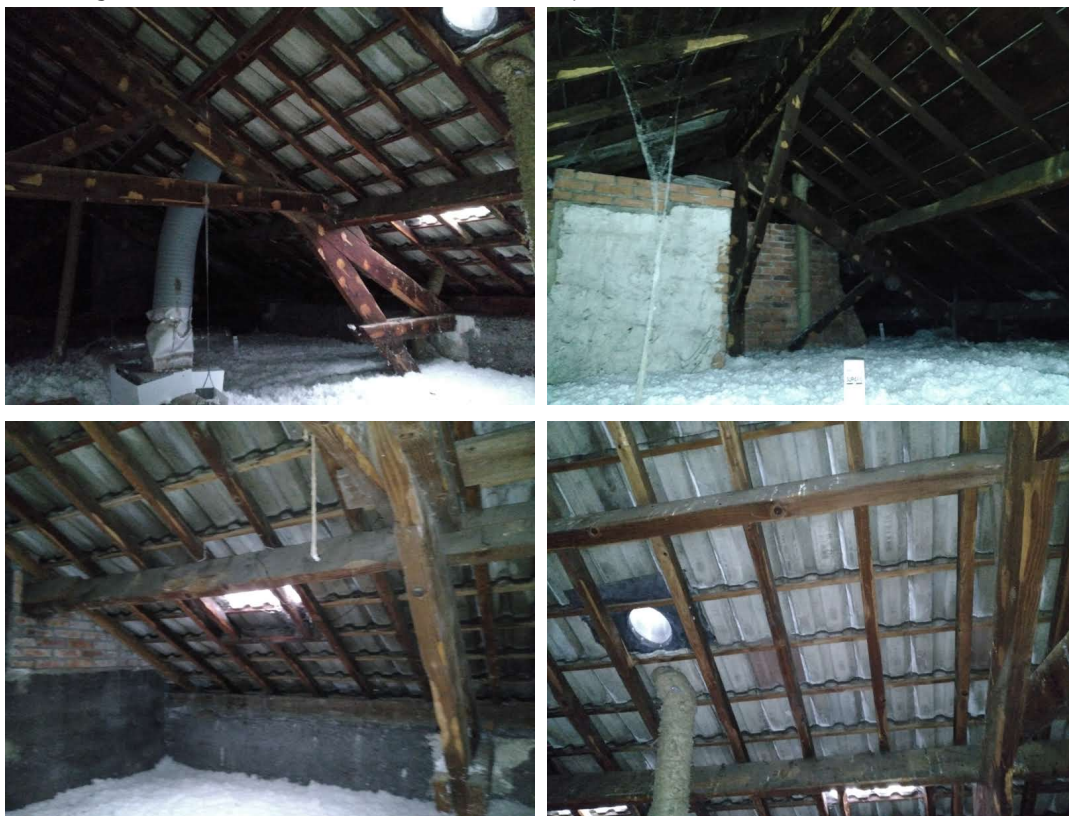
Figure 5 : Combles des bâtiments concernés par les travaux de rénovation de toiture
