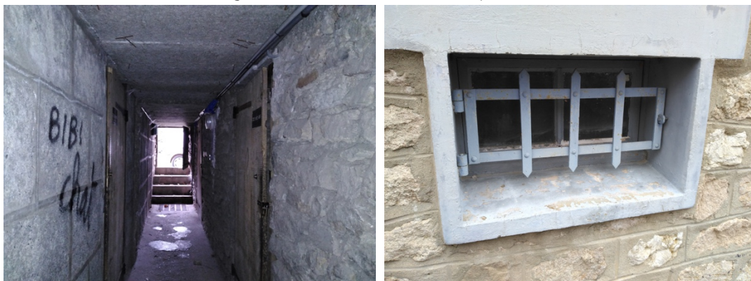
Figure 6 : Caves des bâtiments expertisés
