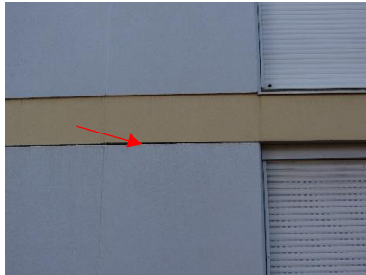
Photos 2: Joints favorables entre chaque étage, façade ouest et aux extrémités de la façade est.
