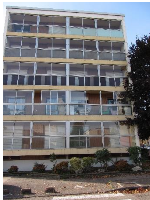
Photos 6: Pignon nord, balcons vitrés.
