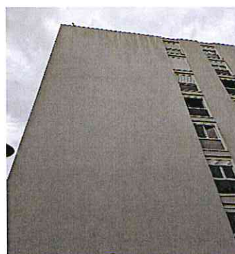
Photos 2: Aucun gîte potentiel sur le bâtiment 7.
