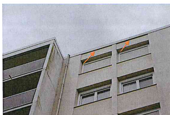
Photos 3: Espaces entre la couvertine et la façade, favorables aux chauves-souris.
