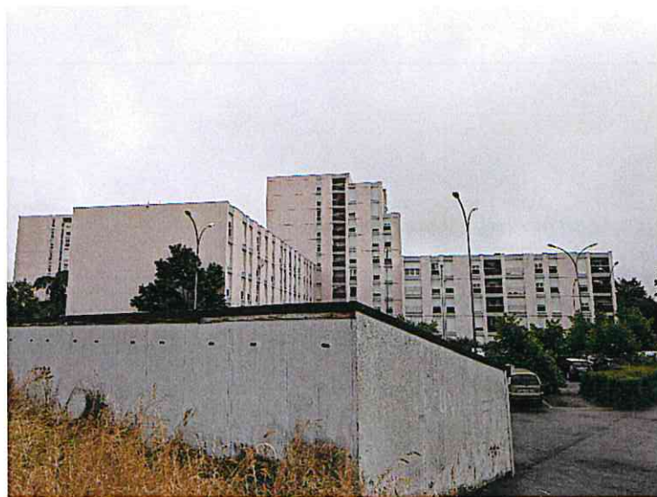
Photo 1 : Vue des bâtiments 21 à 27, façades sud-ouest.
