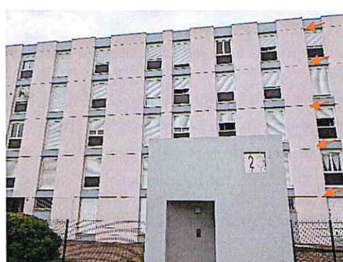
Photos 3: Joints de dilatation entre étages, favorables aux chauves-souris.
