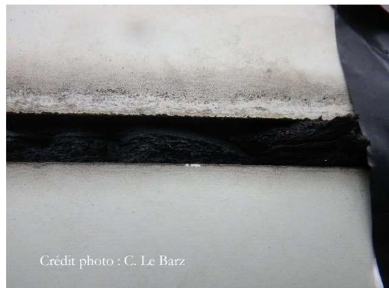
Figure 37 : Exemple de condamnation avec des « boudins » de mousse d'isolation de tuyau de chauffage
