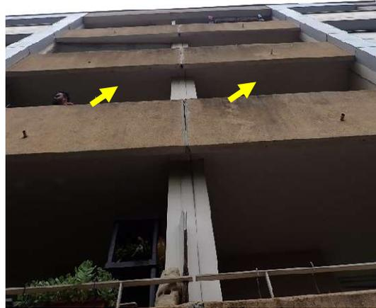
Figure 17 : Joints présents au-dessus des balcons
