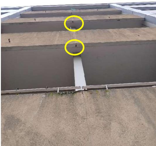
Figure 18 : Joint vertical "fermé"
