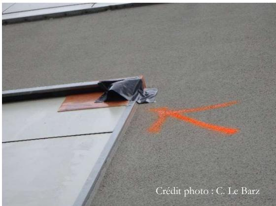
Figure 36 : Exemple de système anti-retour équipé d'une casquette anti-retour
