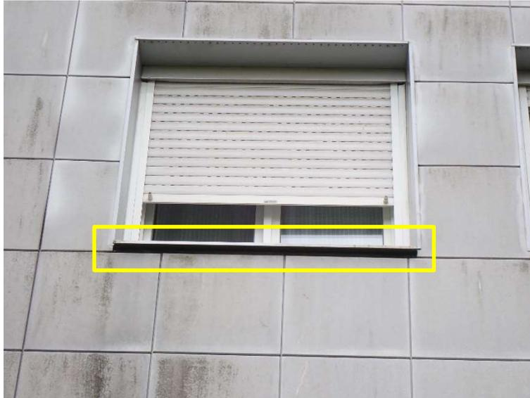
Figure 11 : Espace entre la tablette de fenêtre et la maçonnerie
