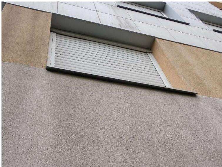
Figure 14 : Absence d'espace entre le coffret de volet roulant et la maçonnerie
