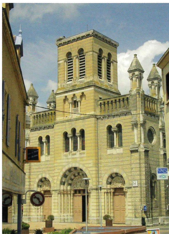
L'Hirondelle de fenêtre niche sur toutes sortes de bâtiments. Église de Digoïn (71).
