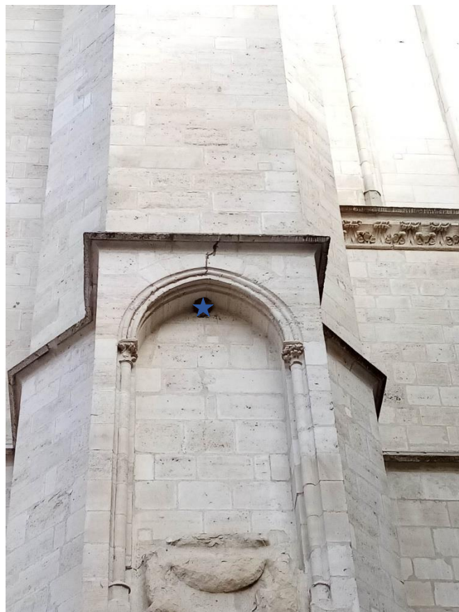
Droite de la façade
