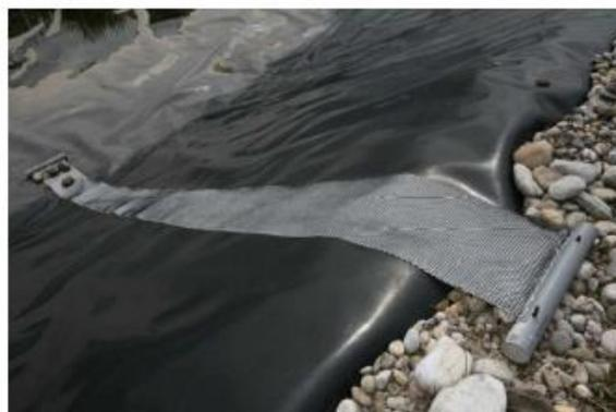
Figure 29. Echappatoire installé sur un bassin de type bâche plastique
