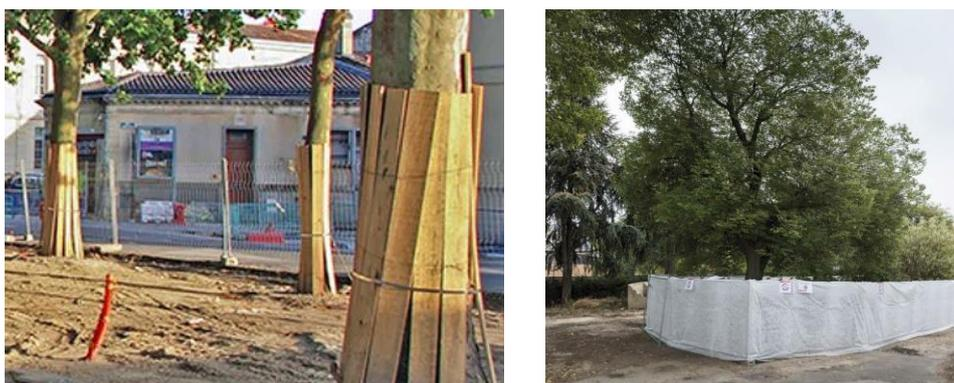
Figure 34. Exemple de mesures de protection des individus arborés conservés
