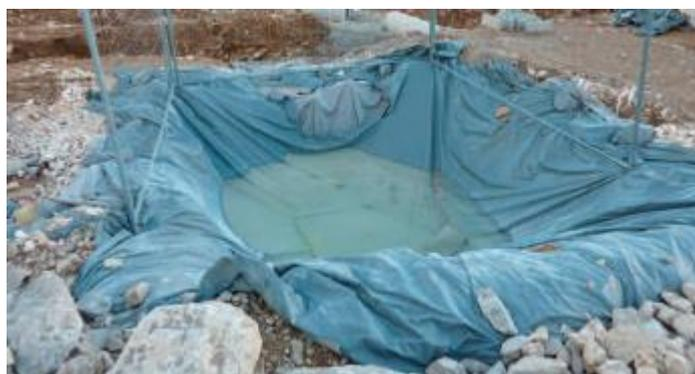
Figure 30. Stockage de matériaux polluants sur lieu étanche (à gauche) et fosse étanche de récupération des résidus de nettoyage, laitance béton, etc (à droite)
