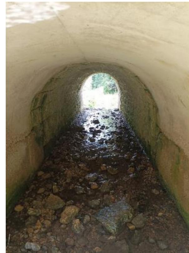
Figure 9 : Section 2-5 - Vue intérieure de la buse du bief de la Chaille
