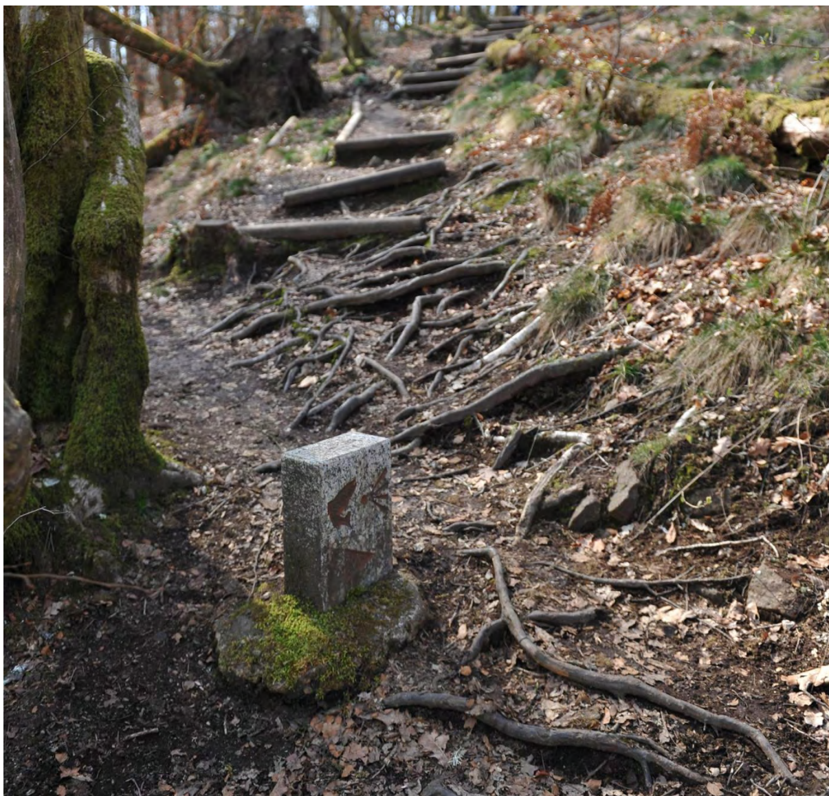
De nouveau une borne de granite, implantée dans le sentier et déchaussée : la galette de béton de scellement émerge nettement du sol.
