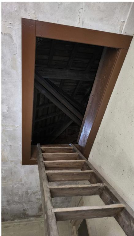
L'accès aux combles se fait par un escalier bois depuis le 1<sup>er</sup> étage. Une porte au sol permet de fermer ou non son accès. Celle-ci, ouverte sur la photo de droite ci-dessous, sera refermée et découpée sur un tiers de sa surface pour accueillir un dispositif de comptage des passages de chauves-souris en vol.
